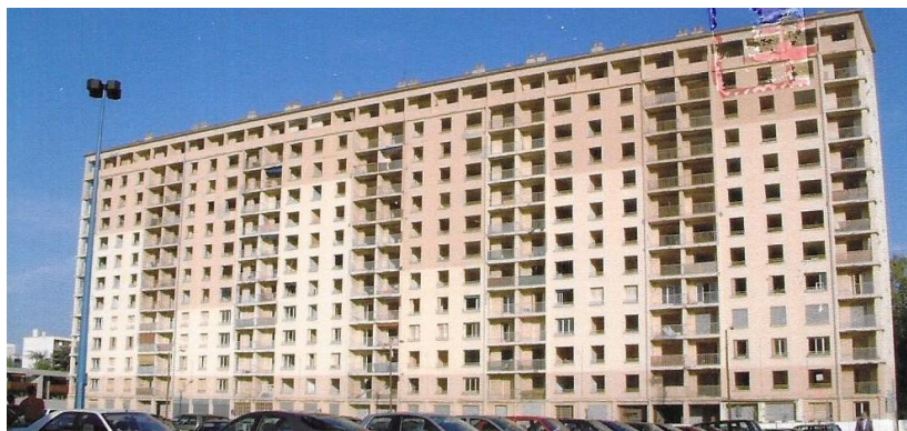
Surnommé "la barre" et assisté d'un vaste parking, l'immeuble de la Cité Antonin Perrin avait 13 étages, 3 allées (avec ascenseur chacune) et, derrière (voir dans le rond rouge), une aile n'ayant que 8 (ou 9) étages. Réalisation typique de la période des "Trente Glorieuses". Photos prises ici et ci-contre à dr., vers 1990-95.
