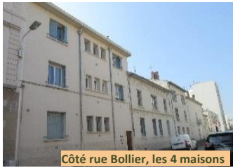
Côté rue Bollier, les 4 maisons
