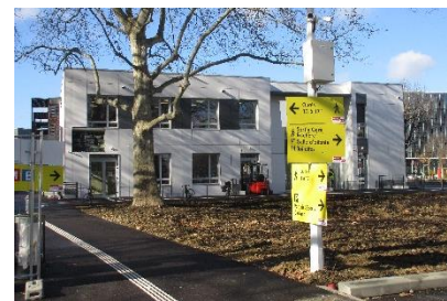
Bâtiment voyageurs et accueil : la flèche de la pancarte jaune n'est pas tournée du bon côté. Photo 29 janvier.
