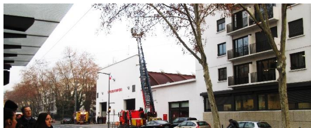
Caserne des sapeurs-pompiers de Gerland, 19 avenue Debourg. Photo prise depuis le quai du tramway T 1, station ENS, en face de la caserne, le 15/02/2023.
